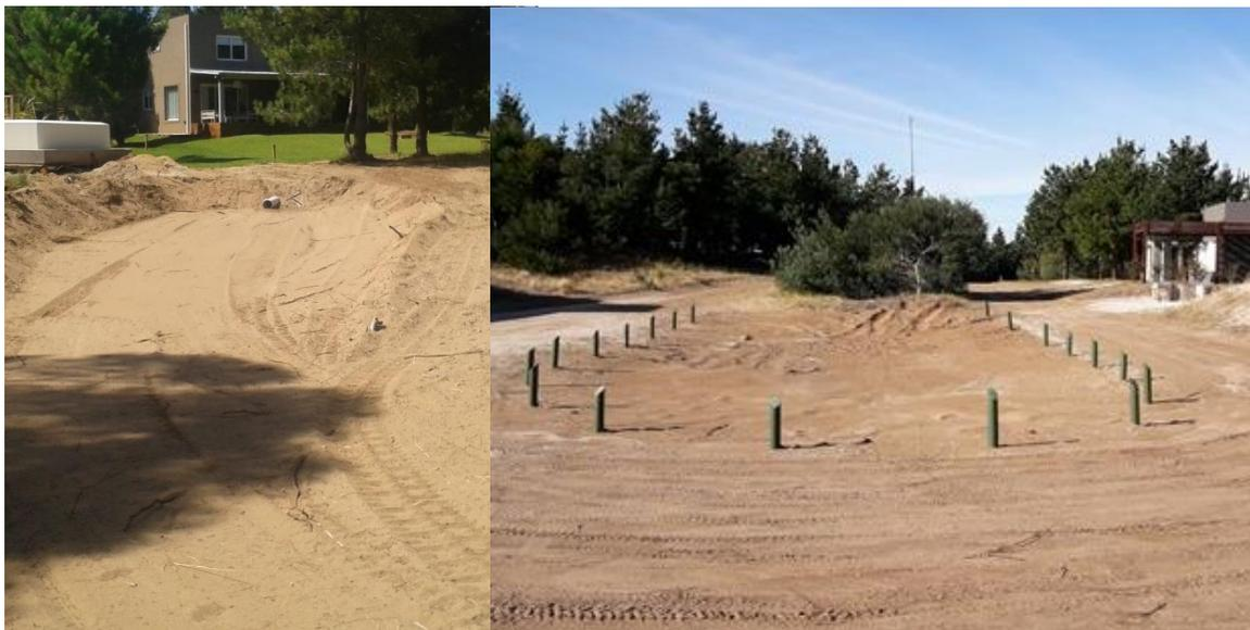
**Figura 3.** Derecha salida de entubado a dren en bajo natural, izquierda dren construido en cul de sac. Elaboración propia.
